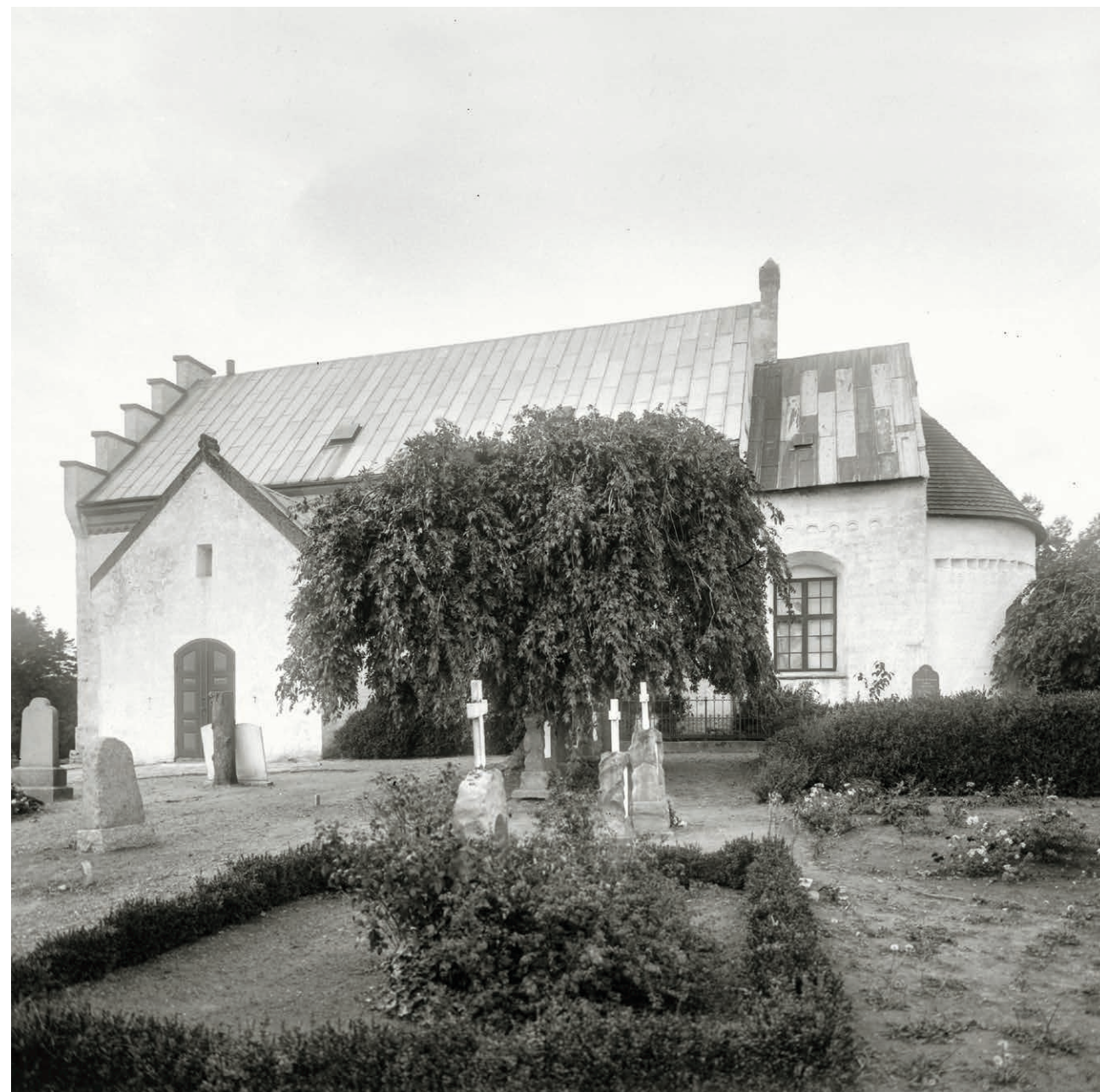
Skt. Povls Kirke, foto 1918, Chr. A. Møller, Rønne. På dette fine billede ses, at den øverste række rundbuer på apsis er blevet overkalket efter 1878. Måske ved kirkens restaurering i 1881. Korets lavtplace-rede rundbuer er tydelige. Det er ganske usædvanligt og tyder på, at koret må være blevet forhøjet på et senere tidspunkt. Vestgavlens nygotiske kamtakker er en tilføjelse fra kirkeskibets forlængelse i 1871. Bornholms Museum.
